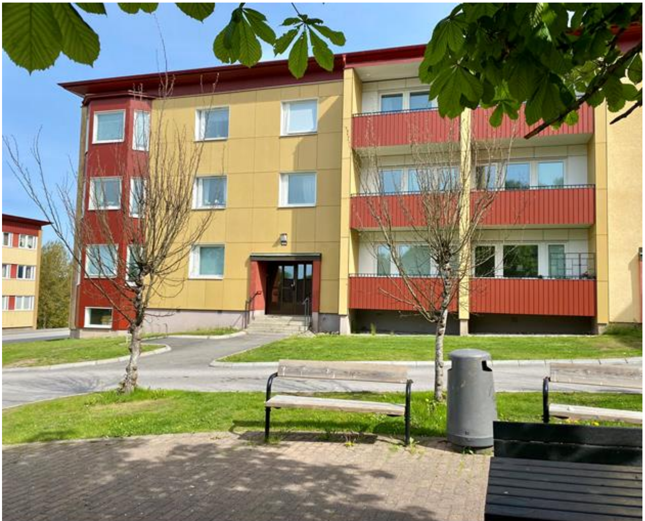
Nillass väg 30 (Vättersholm 2) ombyggnation av fönster och fasad
