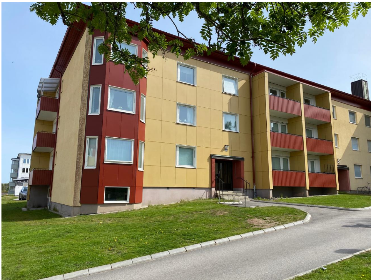
Nillas väg 30 (Vätersholm 2) ombyggnation av fönster och fasad
