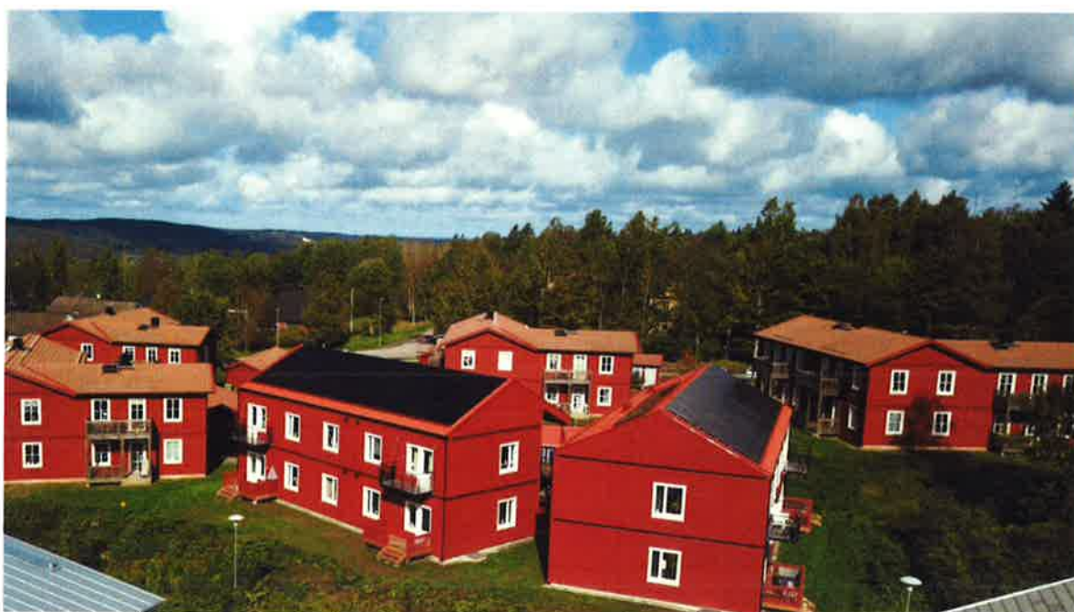
Hagtornet 1, Åtta nya lägenheter och ny solcellsanläggning 2018
